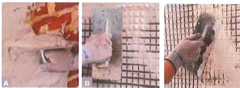
Fig. 25 – Aplicarea tencuielii armate
