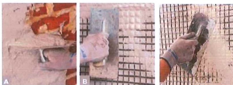
Fig. 25 – Aplicarea tencuielii armate
