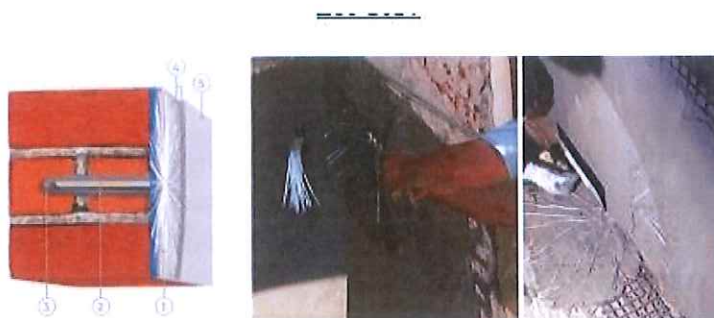
Fig. 26 – Ancorarea sistemului în câmpul pereților
